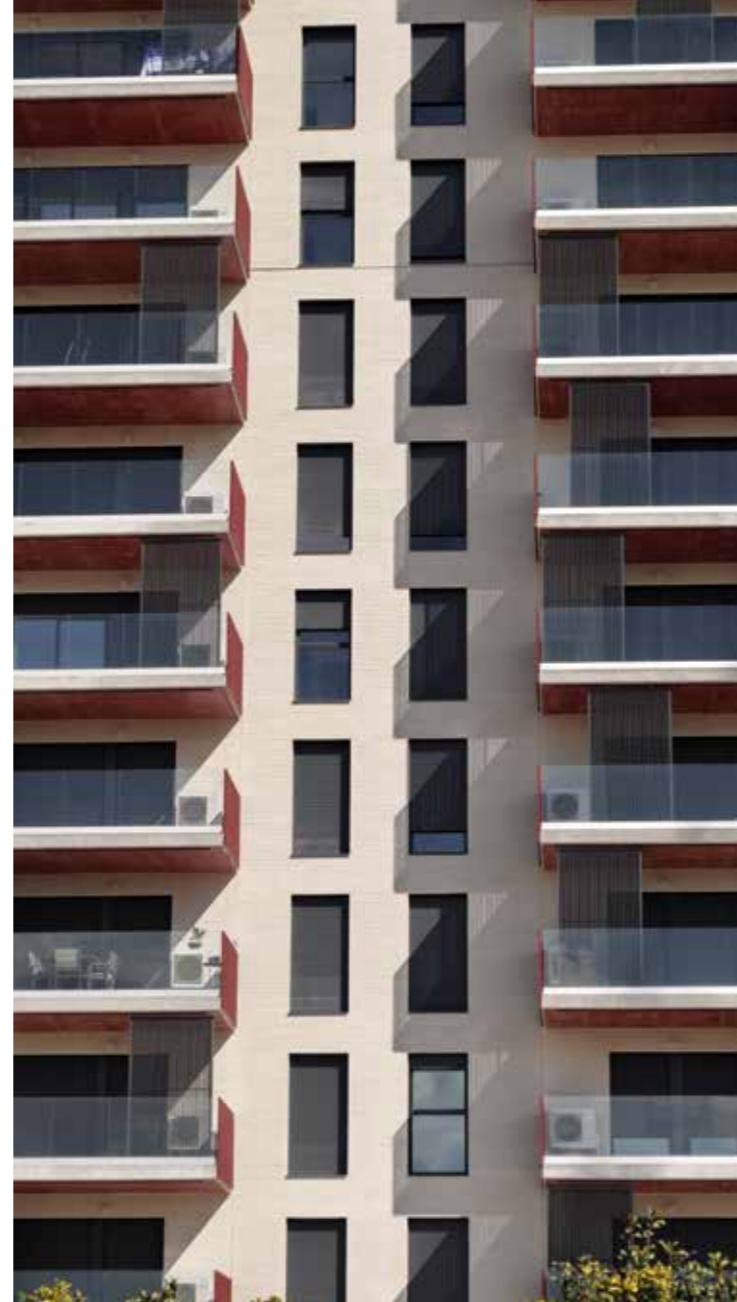
Clinker Atlas. Viviendas en Vinaroz. Castellón. Arquitecto: Curro Mestre Edificio de 14 plantas empleando el sistema de fachada autoportante de ladrillo cara vista.
